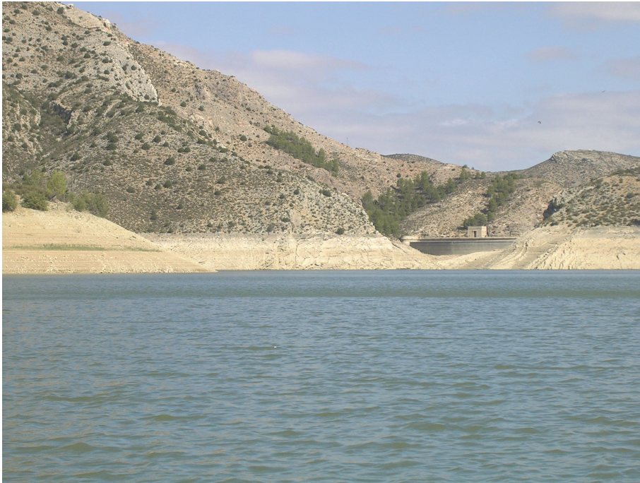
Figura 7: Vista de la presa del embalse
