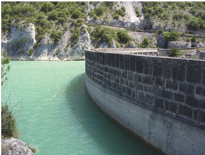
Figura 6: Vista de la presa desde un lateral
