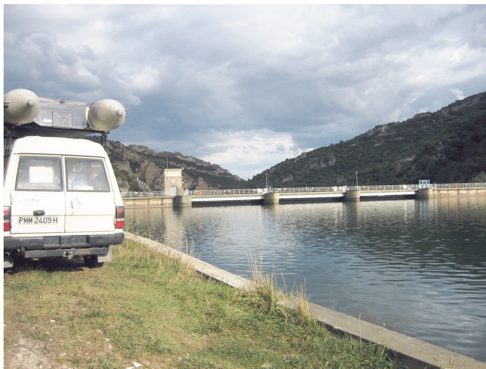
Foto 1: Presa del embalse
