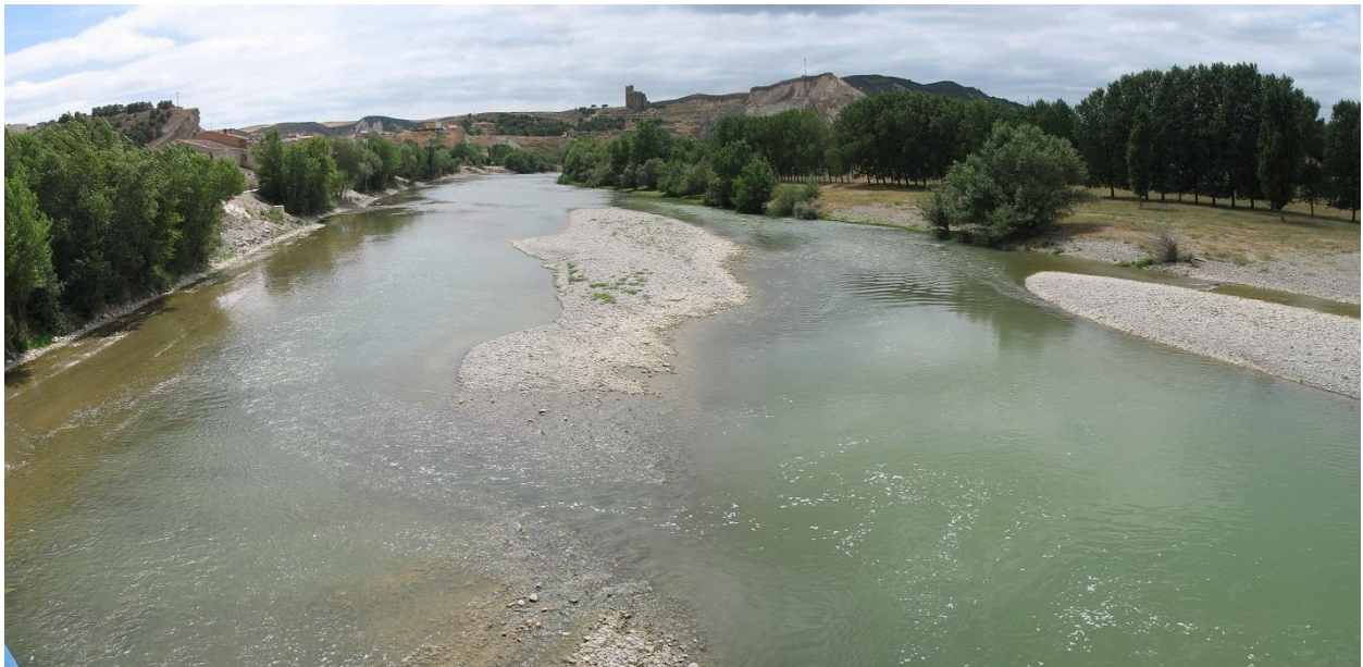
Figura 15-7. Dragado del cauce en la localidad de Caparroso.
