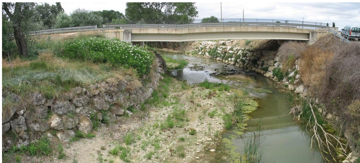
Figura 15-22. Canalización del río Zidacos en la localidad de Olite.
