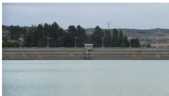
Foto 4: Presa del embalse de Gallipuen
