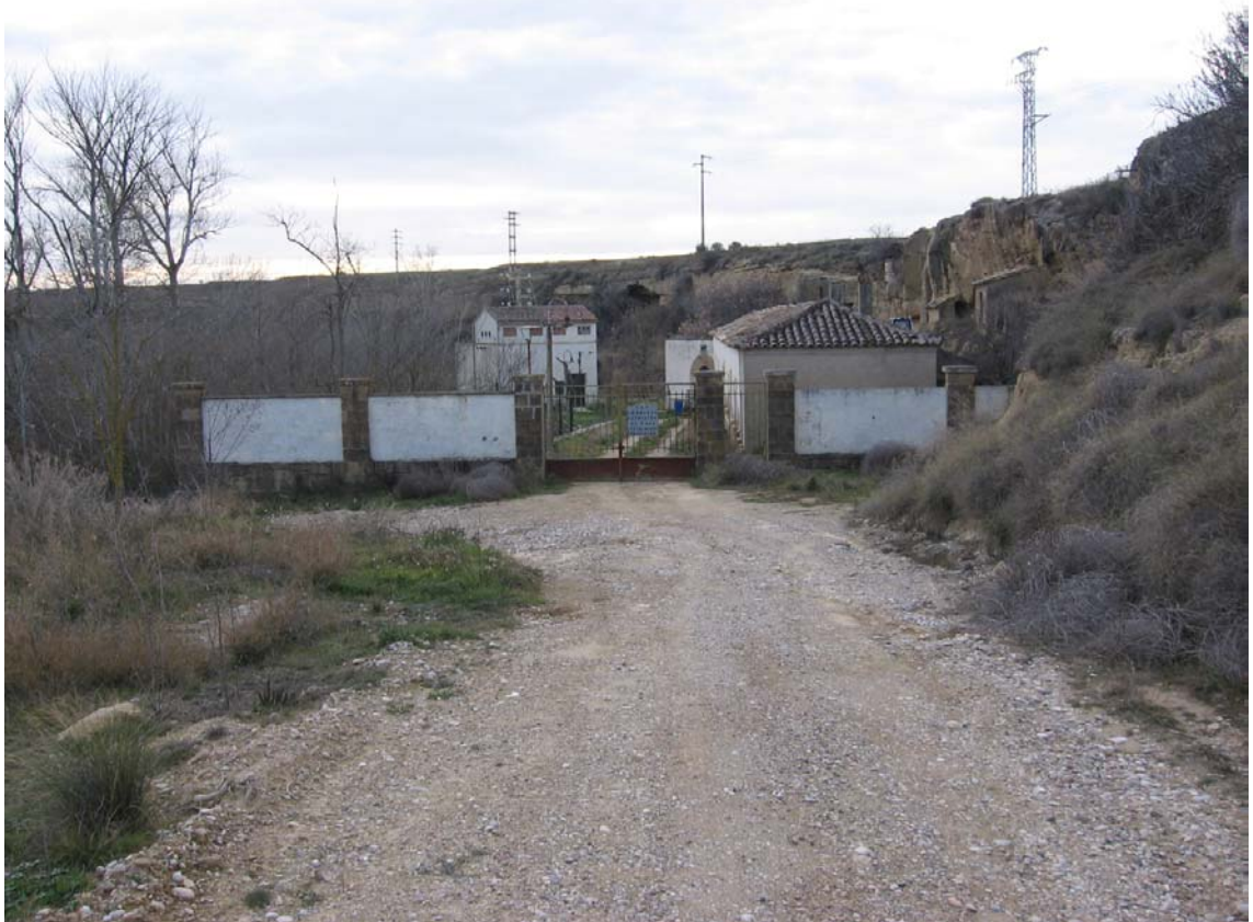
Ref. 40.- Minicentral hidroeléctrica de Huerto: vista general.
