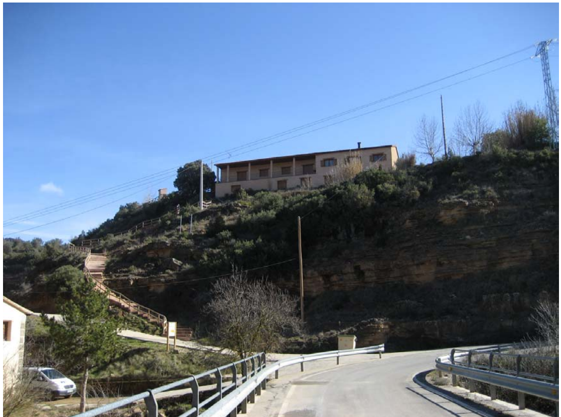
Ref. 16.- CH de Bierge: vista general del albergue de Bierge.
