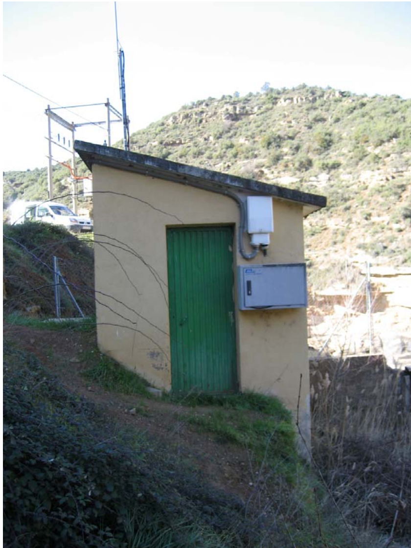
Ref. 15.- CH de Bierge: toma de agua del albergue de la localidad de Bierge aguas arriba del azud.
