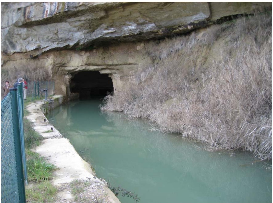
Ref. 38.- Azud de la minicentral hidroeléctrica de Huerto: nacimiento del canal (utilización de una antigua conducción de agua).
