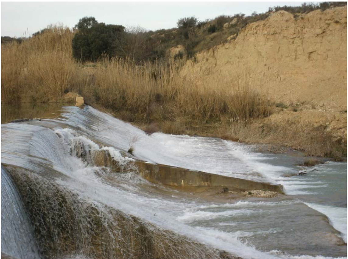
Ref. 36.- Azud de la minicentral hidroeléctrica de Huerto: escalera de peces.
