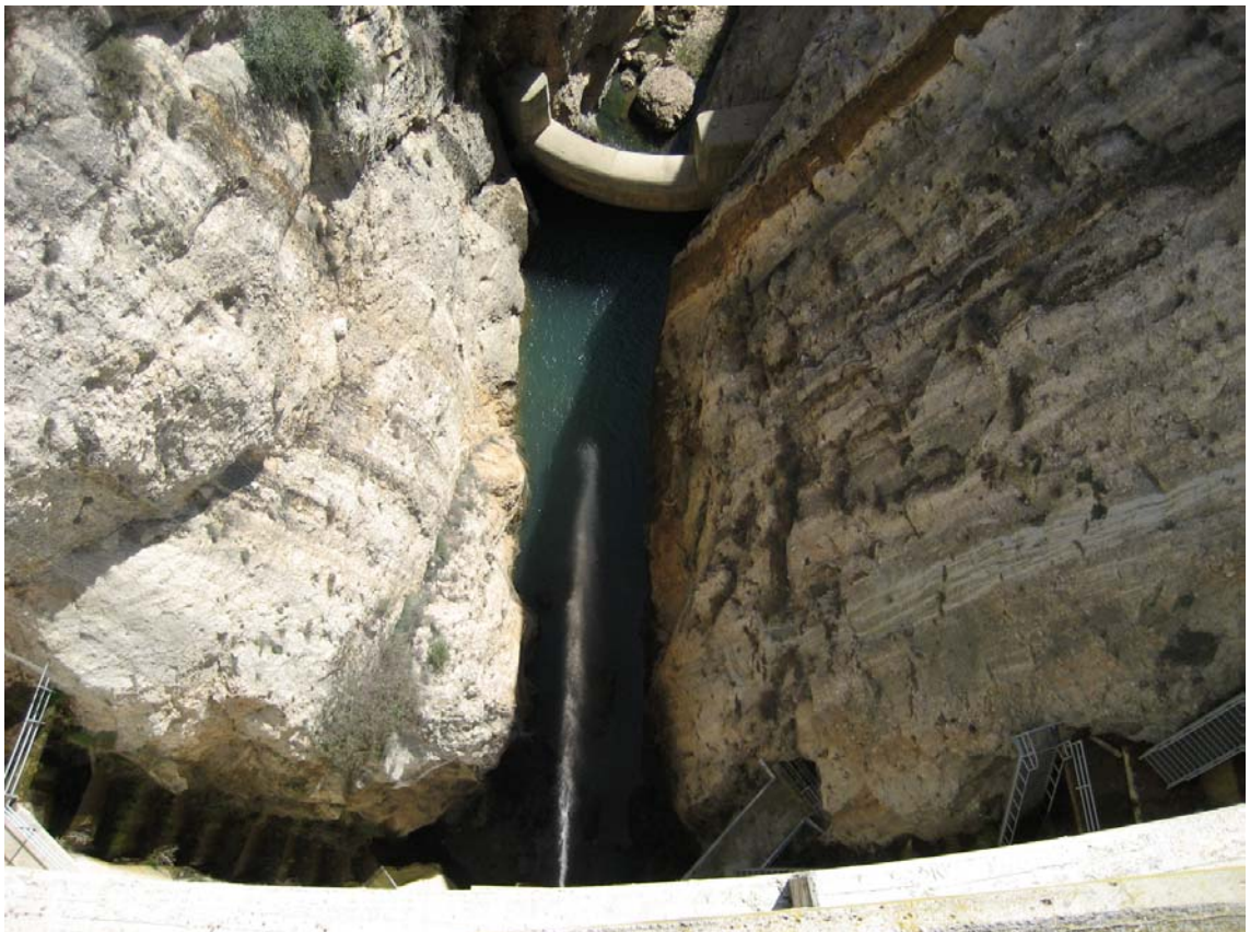
Ref. 22.- Embalse de Guara: detalle del desagüe de fondo.
