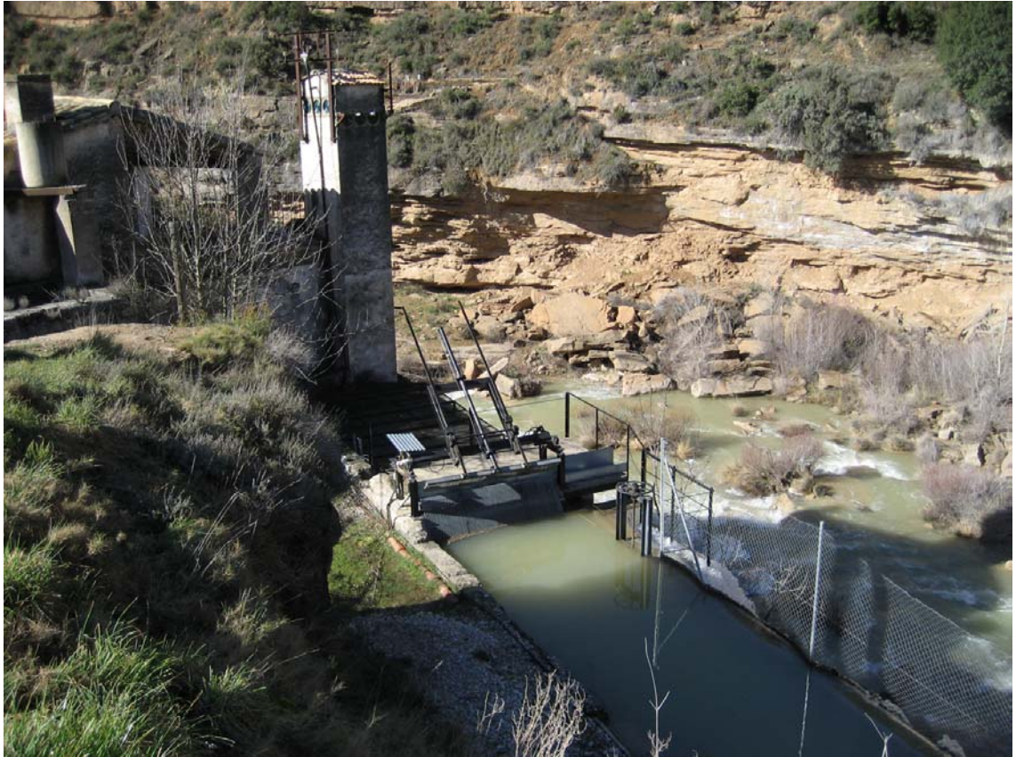
Ref. 13.- CH de Bierge: entrada de agua a la CH.
