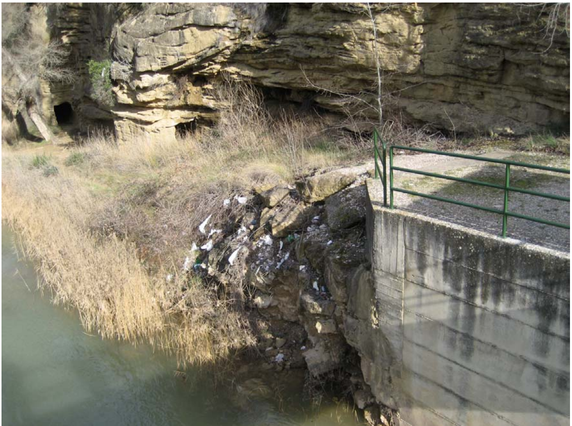
Ref. 30.- E.A. del río Alcanadre en Lascellas: acumulación de basuras en las riberas del río al ser una zona con aprovechamiento lúdico.
