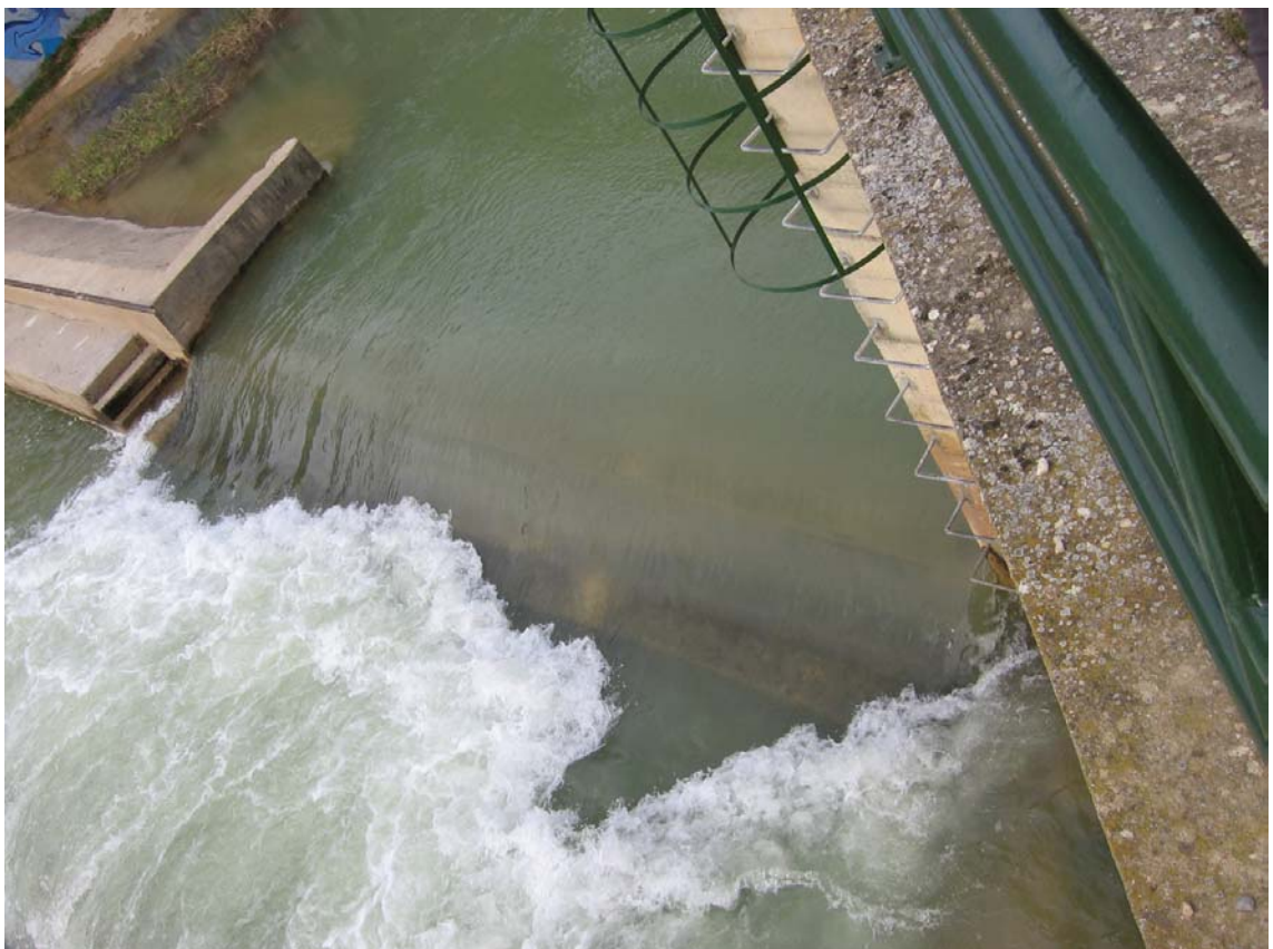
Ref. 28.- E.A. del río Alcanadre en Lascellas: sección de paso para medir el nivel.
