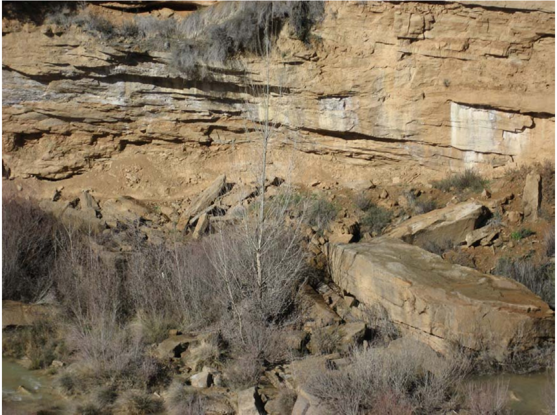
Ref. 17.- CH de Bierge: detalle del desprendimiento de roca de la margen izquierda del río Alcanadre aguas abajo del azud en una zona transitada principalmente en verano.
