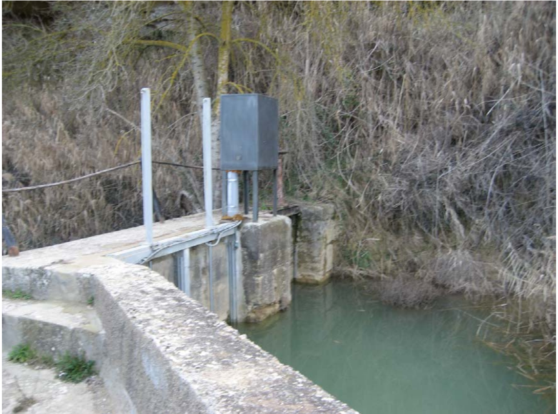
Ref. 37.- Azud de la minicentral hidroeléctrica de Huerto: entrada de agua a la derivación de agua.
