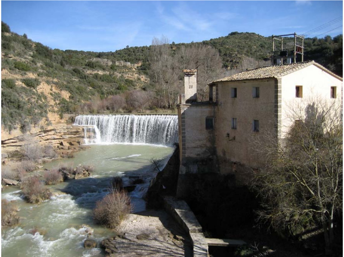
Ref. 11.- CH de Bierge: vista general del azud y la central hidroeléctrica de Bierge situada en el río Alcanadre.
