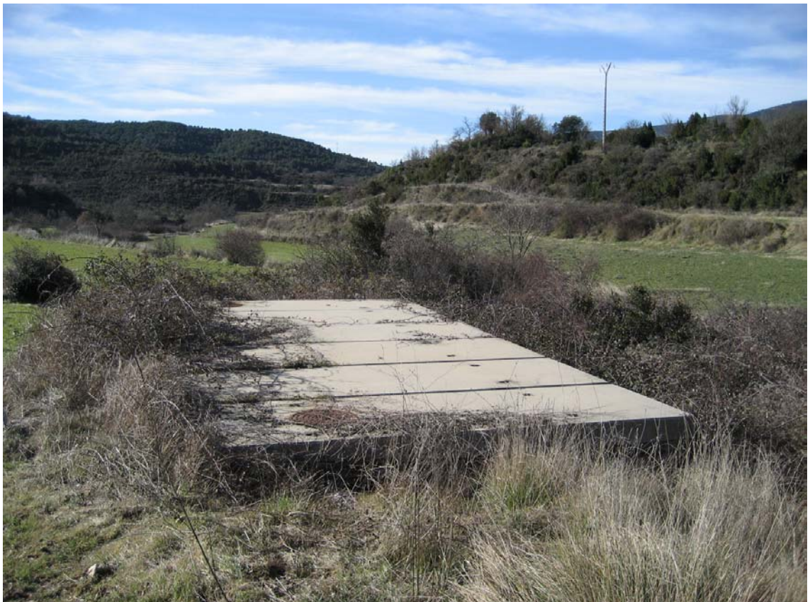
Ref. 6.- Vista de la fosa séptica utilizada para depurar el vertido de la localidad de Las Almunias antes de verter al río Alcanadre a su paso por dicha localidad.
