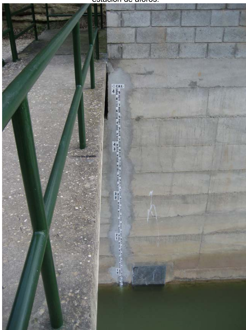
Ref. 26.- E.A. del río Alcanadre en Lascellas: escala para medir el nivel.
