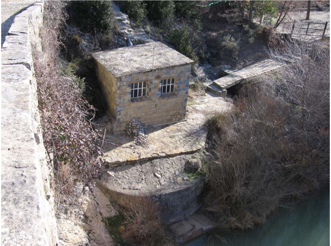
Ref. 5.- Detalle de la toma de agua para abastecimiento al Camping El Puente y al pueblo de Pedruel situada en el río Alcanadre a su paso por el Puente a Pedruel.
