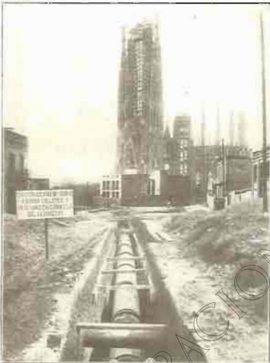
Tubería de 1,00 m. de diámetro. Presión: 8 Kg. / cm 2
