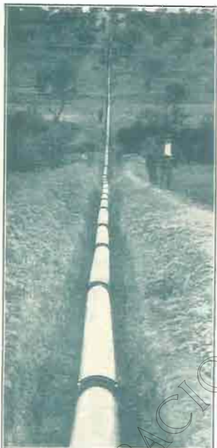
CONDUCCIÓN DE AGUA EN SEVILLA (España) 1000 metros longitud - 30 centímetros diámetro - 11 anillos.
