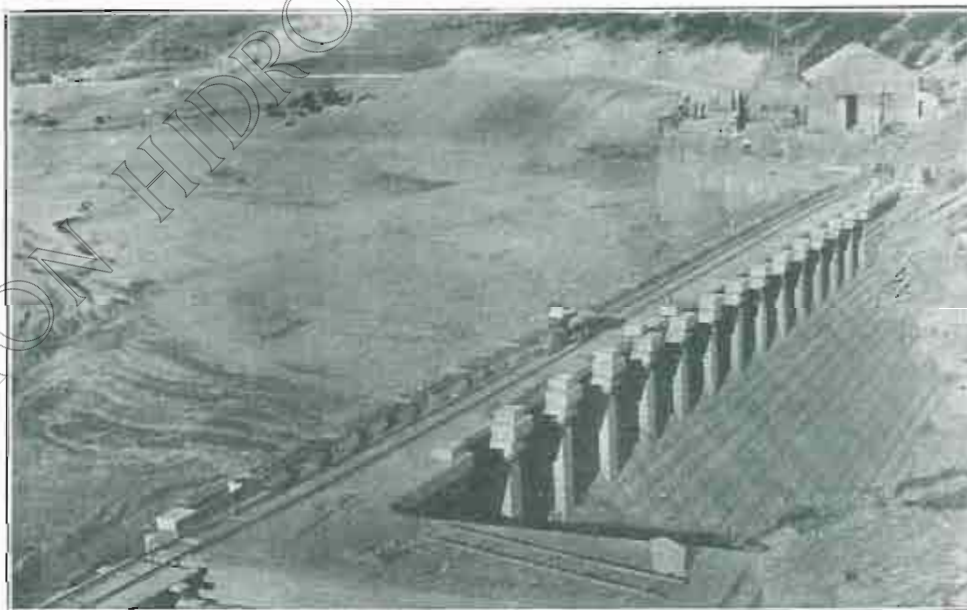
PANTANO DE ARGUIS: Detalles de la coronación de la presa.
