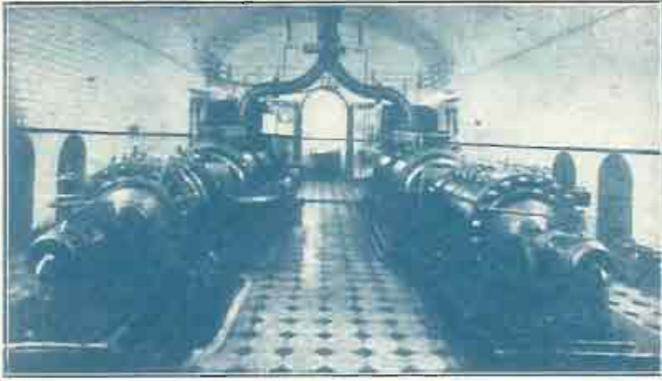
INSTALACION DE LA MINA "ARRAYANES" (JAEN) CUATRO GRUPOS DE BOMBAS 41 litros por segundo, 225 metros altura elevación, 300 HP, cada grupo. Instalación de bombas centrífugas más importante de España.
