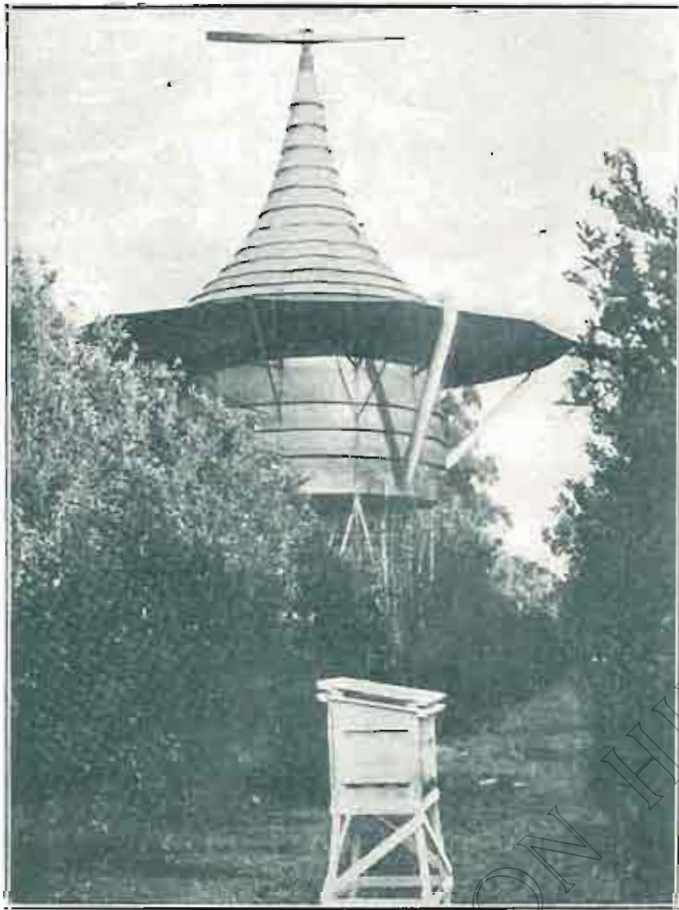
La hélice accionada por un motor, lanza el aire sobre las plantas, después de caldearse éste al pasar junto al cono metálico, que está provisto interiormente de calefacción.
