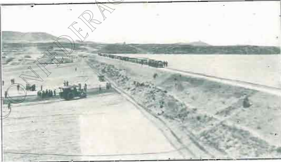
TORMOS: Embalse y construcción de la presa.
