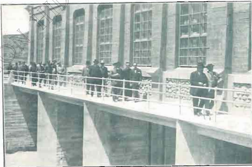
ARDISA: Casa de compuertas.
