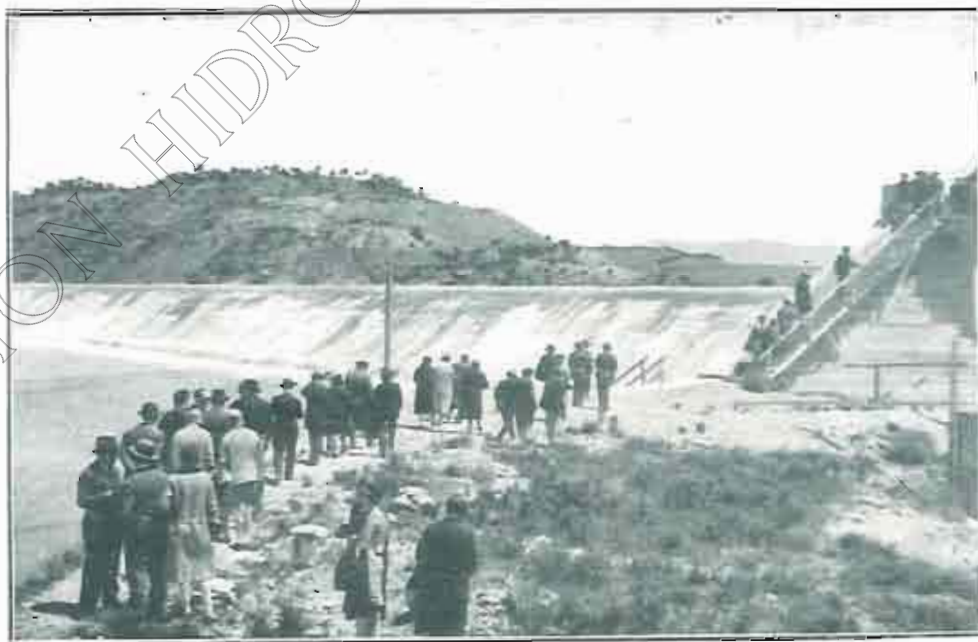
Aliviadero en la presa de Ardisa.
