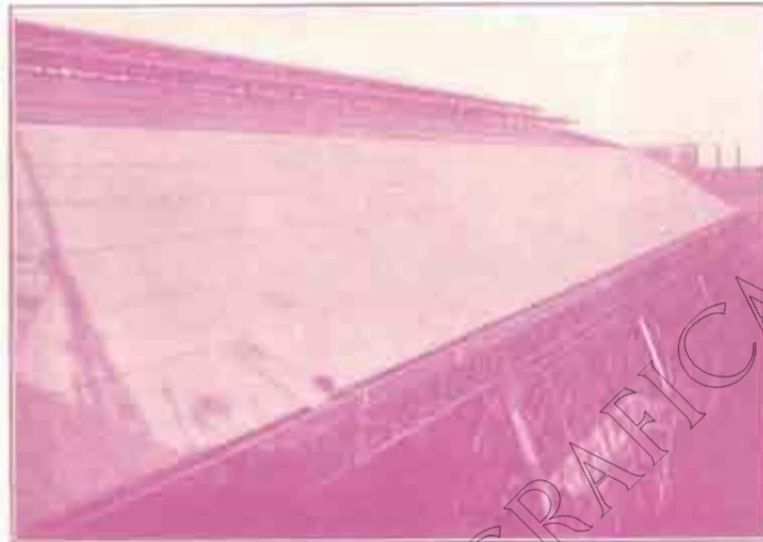
Naves de la nueva estación de M. Z. A. de Barcelona, cubiertas con placa CANALETA
