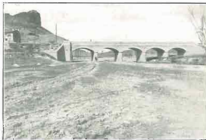
Puente sobre el Ribota, en la carretera de Soria a Calatayud
