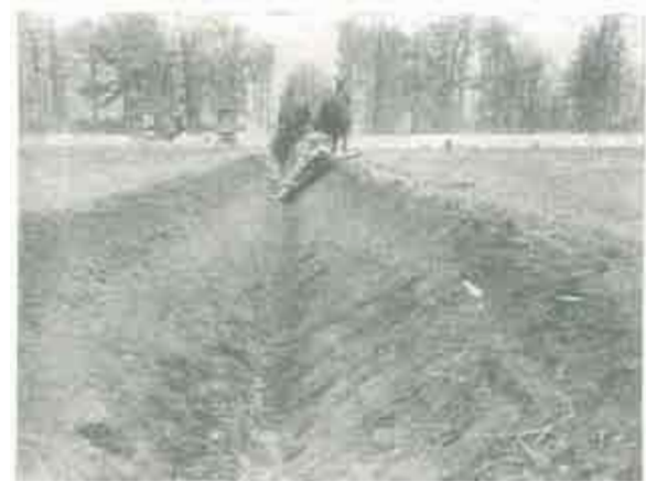
Figura Núm. 24. Completando la zanja.
