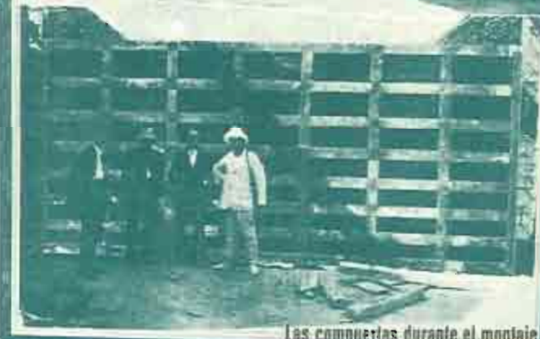
Las compuertas durante el montaje
