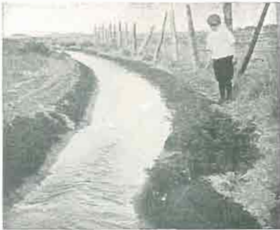
Fig. Núm. 25. Zanja construida con estos aparatos.
