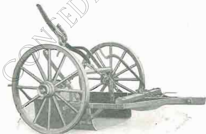
Fig. Núm. 9. Trailla o pala sobre ruedas en posición para cargar.
