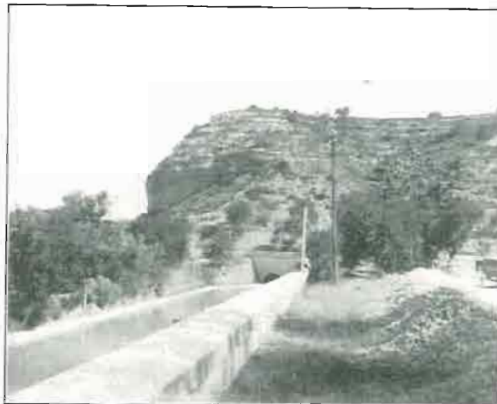
Mina de Borrugat. (Tunel del Canal)
