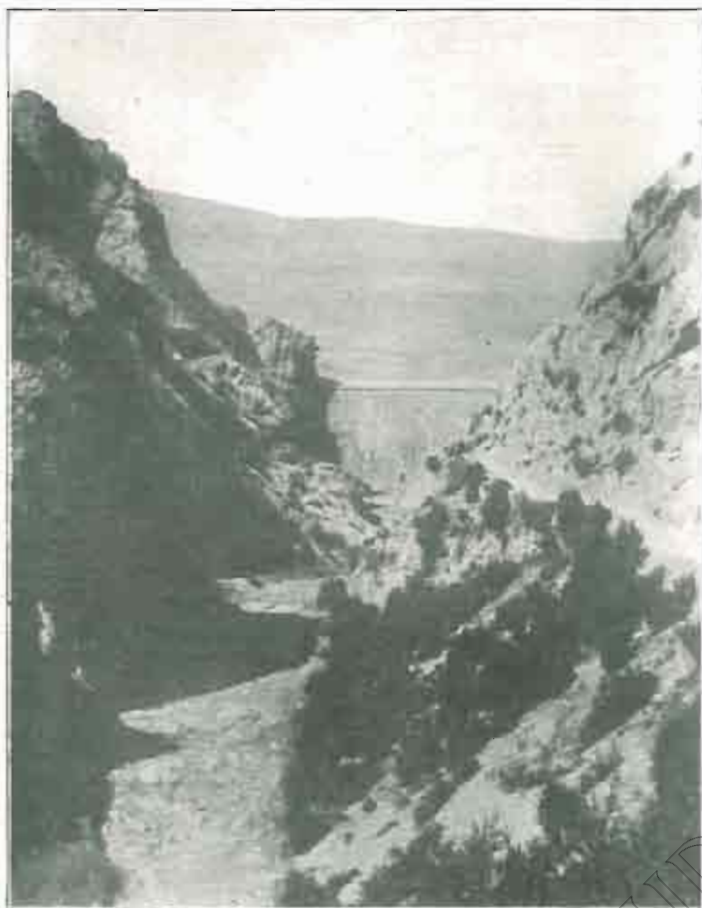
PANTANO DE ARGUIS: Presa antigua, vista desde aguas abajo y único camino de acceso al pantano y al pueblo
