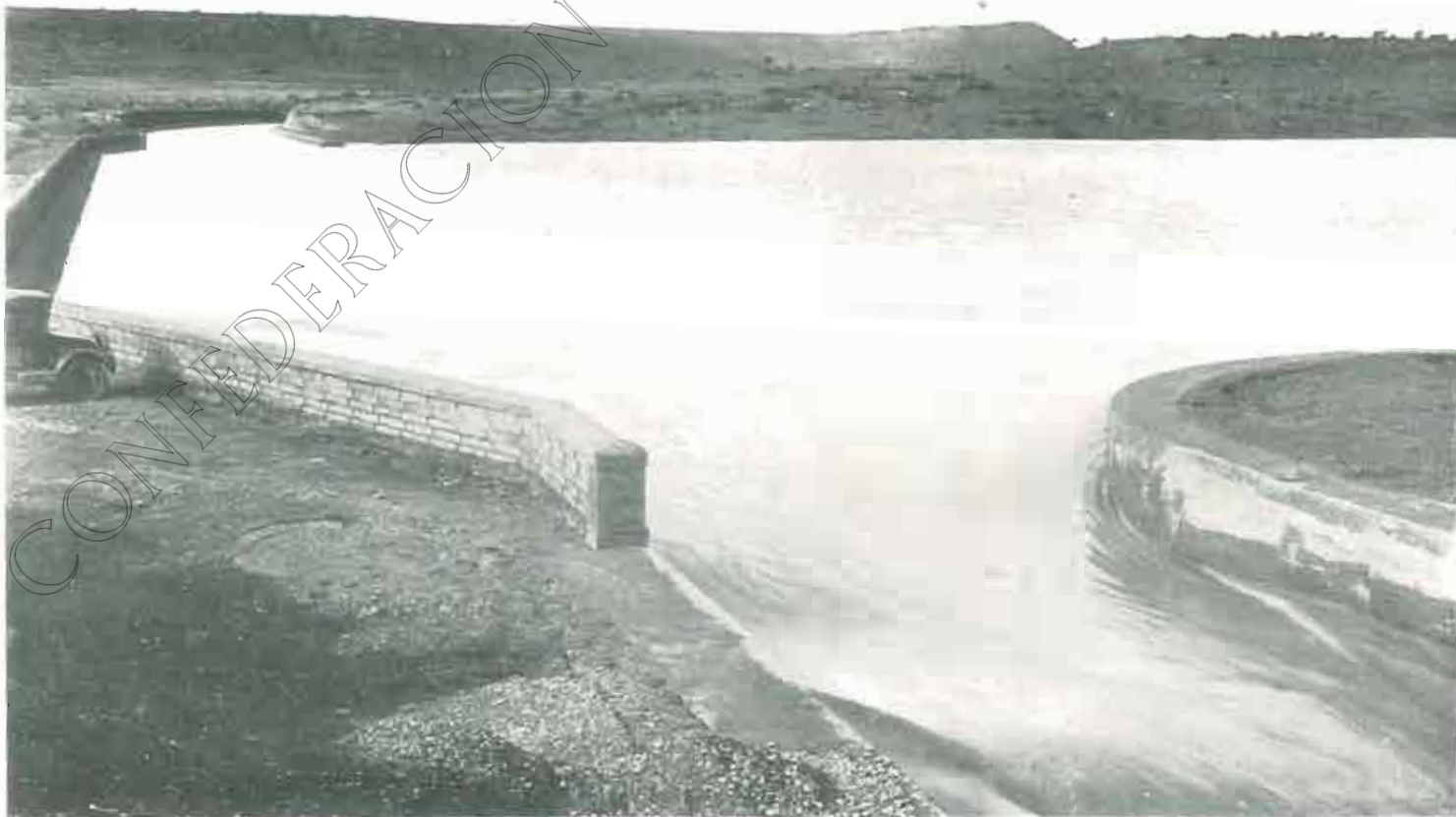
RIEGOS DEL ALTO ARAGÓN: Presa de Puipullín
