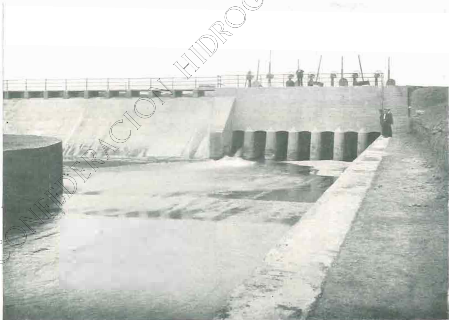
Ventadero y compuertas de limpia en el origen del Canal de Monegros
