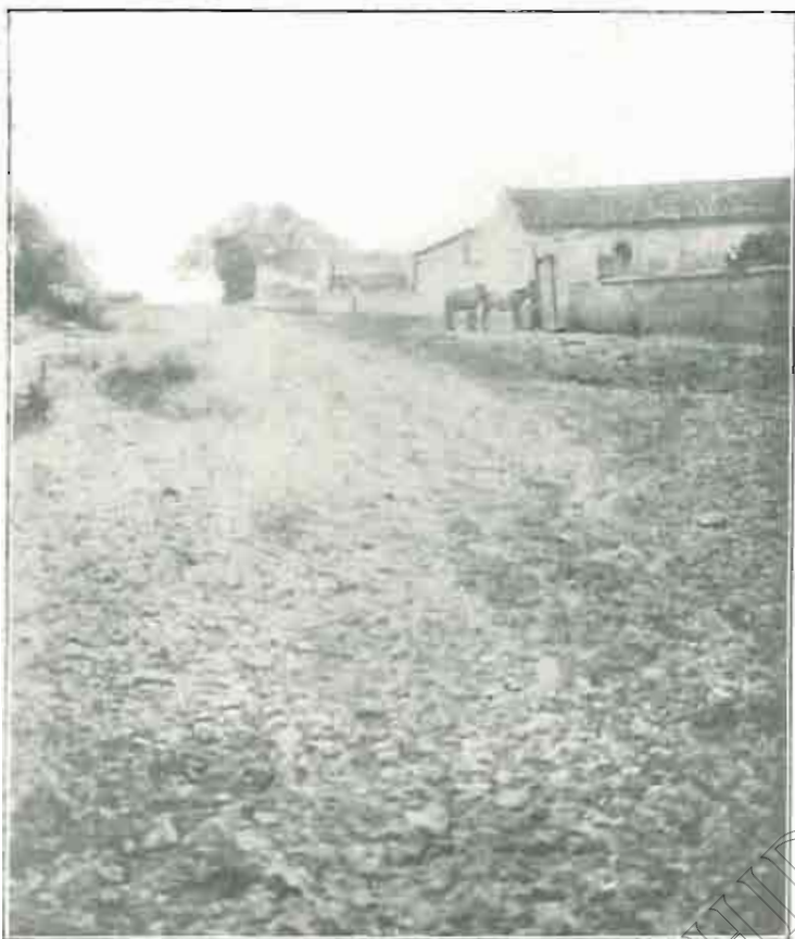
Un trozo de la carretera entre Bágüena y Luco, destruida por los arrastres sólidos de las ramblas.
