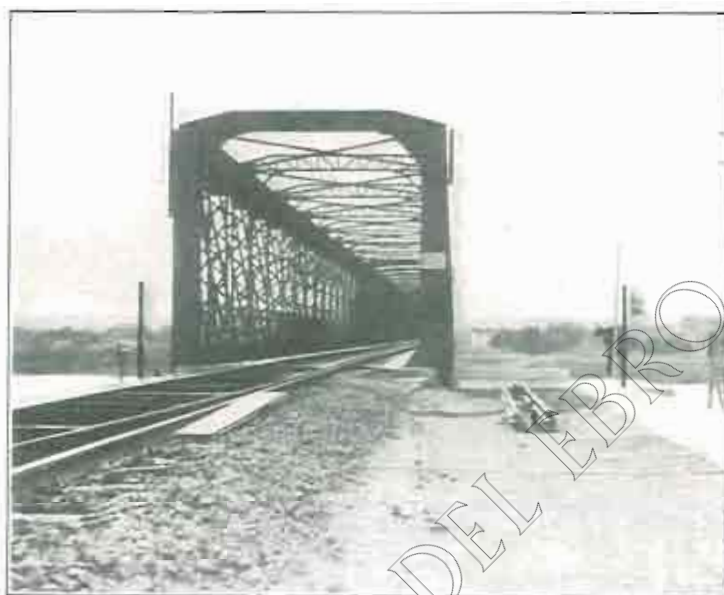
Puente del ferrocarril, (en la parte superior del estribo) N. F.
