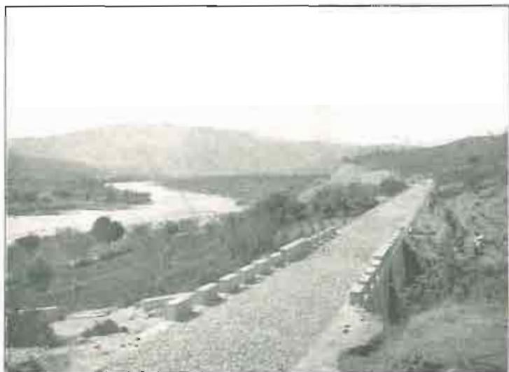
Variante de la carretera de Graus.
