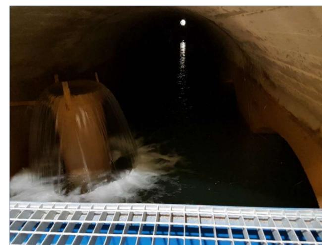
Figura 40. Entrada de agua al depósito de Montearagón
