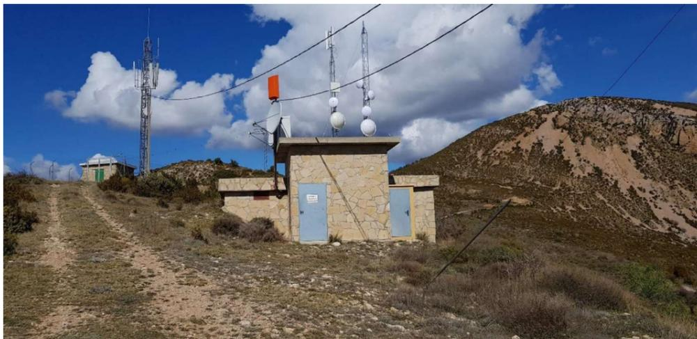
Figura 27. Vista del depósito de Santa Eulalia la Mayor, ubicado en lo alto del municipio, punto en el cual se eleva el agua desde el río y a través de un pequeño depósito intermedio
