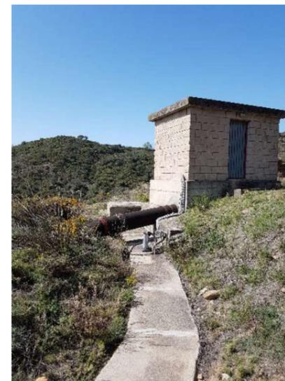
Figura 20. Arqueta unión canal de Huesca y la tubería procedente del bombeo
