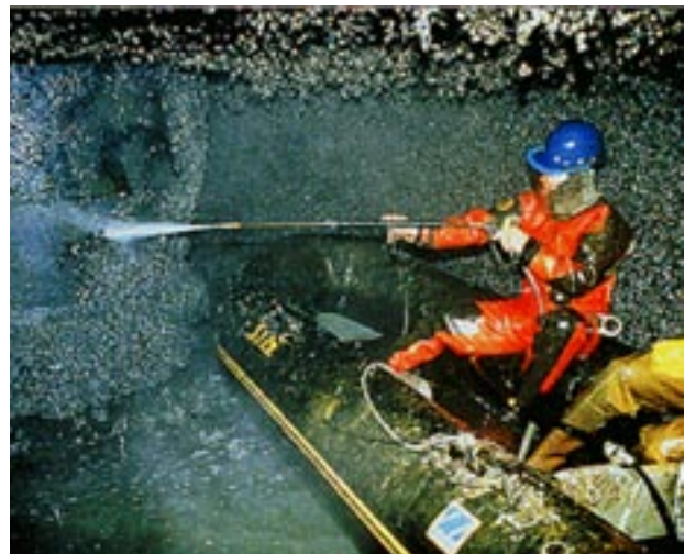
Limpieza con chorro de agua a alta presión.
