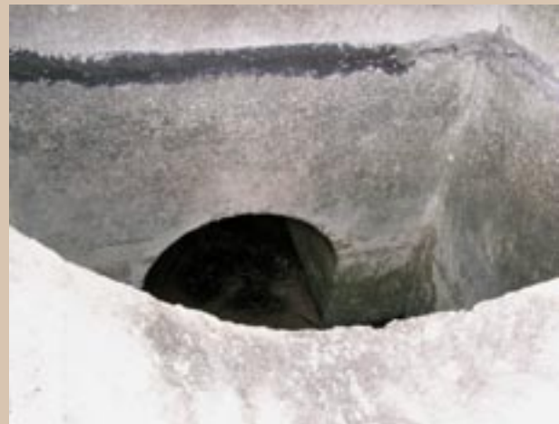
Aspecto interno del sifón.
