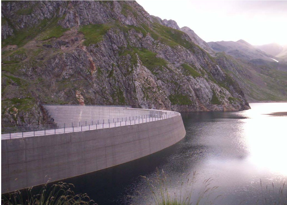
Detalle de la presa del embalse de Llauset. Verano de 2004 (05/08/2004)
