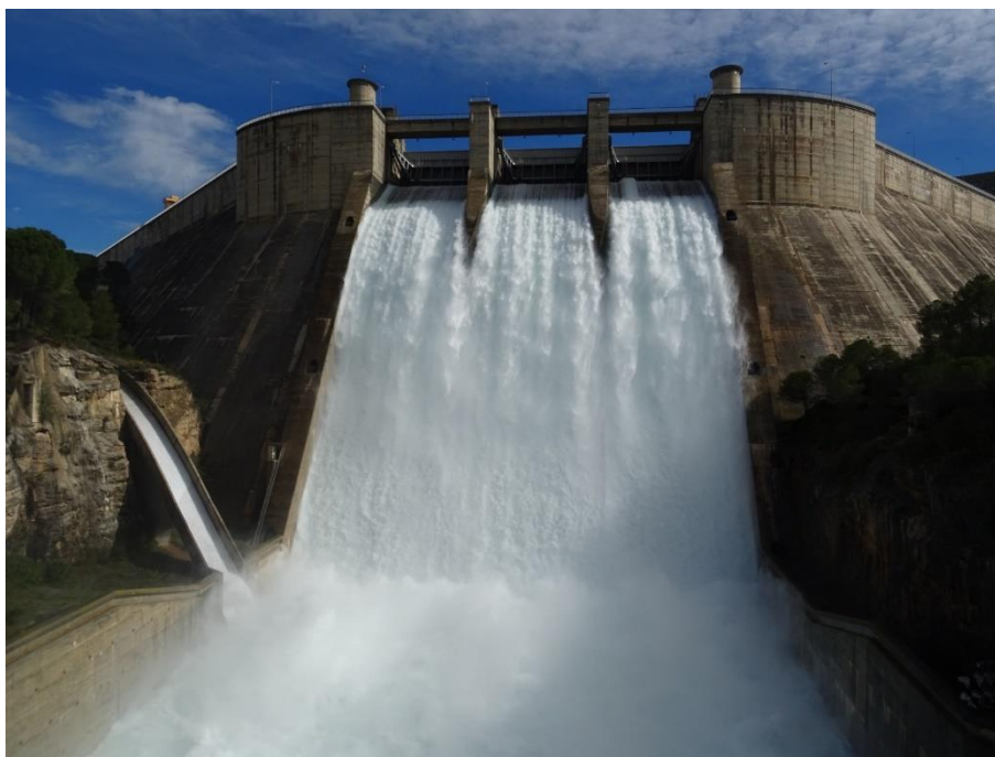
Fotografía 12. Presa de El Grado, suelta controlada. Abril de 2024.
