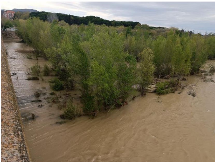
Fotografía 16. Río Cinca en Fraga. Vista hacia la margen derecha. Inundación de isla e inclinación de la vegetación
