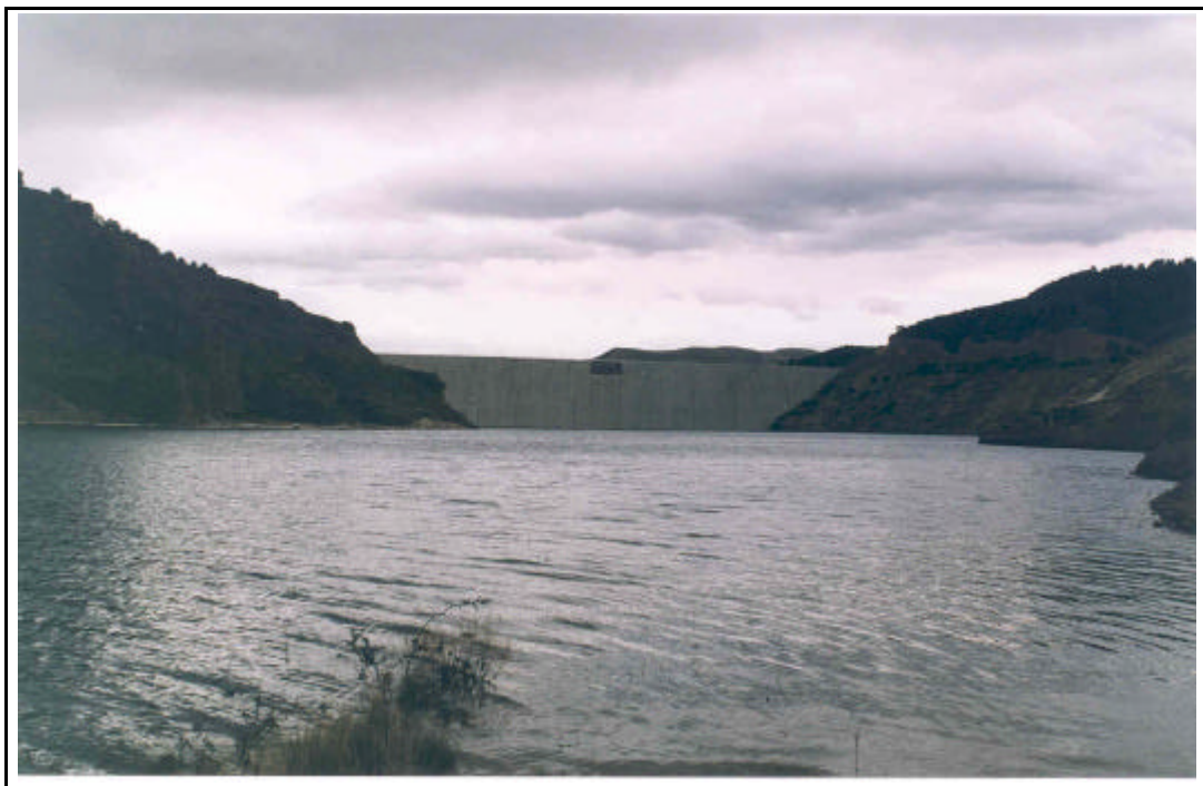
Fotos 1 y 2 Panorámicas de la presa de Val.
